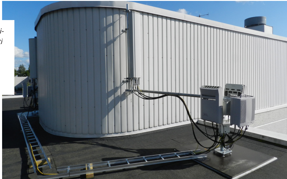
Mobiilitukiaseman yksi antennisuunta sisältää monia soluja per operaattori ja asennus vaatii painavia apurakenteita sekä paljon tekniikkaa. Kuvassa on yhden operaattorin 2G/3G/4G tekniikkaa.
