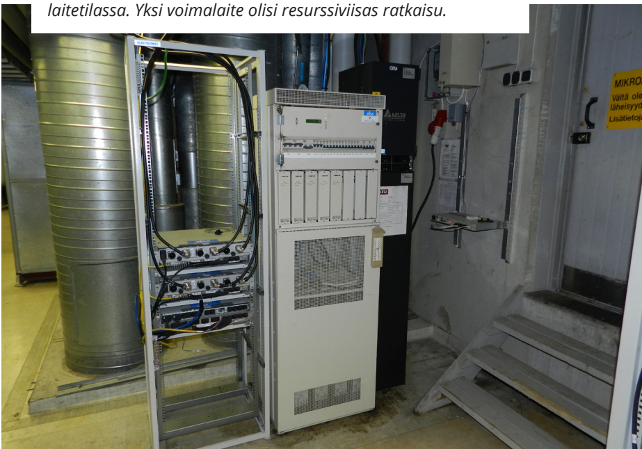
Kuvassa kahden eri operaattorin voimalaite ja akusto samassa laitetilassa. Yksi voimalaite olisi resurssiviisas ratkaisu.
