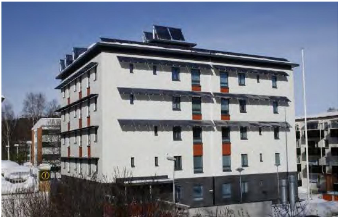
Kuva 2-11 Kuopion nollaenergiatalon julkisivu. Aurinkopaneelilipat mahdollistavat auringon säteilyn lämmittävän vaikutuksen talvikuukausina, mutta estävät ikkunoiden läpi pääsevää lämmittävää säteilyä erityisesti kesäkuukausien aikana. (Kuvan lähde: http://www.nollaenergia.fi/kuopiontalo.php )
