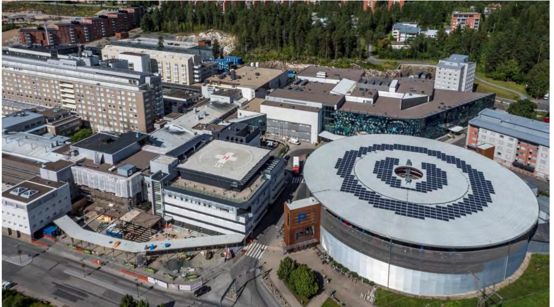
Kuva 3-2 Kuopion yliopistollisen sairaalan pysäköintitalon päälle asennettu aurinkosähköjärjestelmä. (Kuvan lähde: Kuopion yliopistollinen sairaala)
