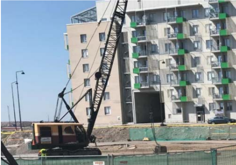
Kuva 20 Pudotustiivistys on hyvä esimerkki pitkäkestoisesta melua aiheuttavasta työvaiheesta, josta on selkeitä haittoja vastapäisen rakennuksen asukkaille
