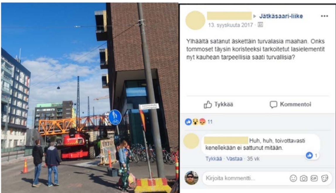
Kuva 17 Jätkäsaarella tapahtunut epäonnistunut parvekkeen kaidelasin nosto päättyi nopeasti Jätkäsaaren Facebook-ryhmään
