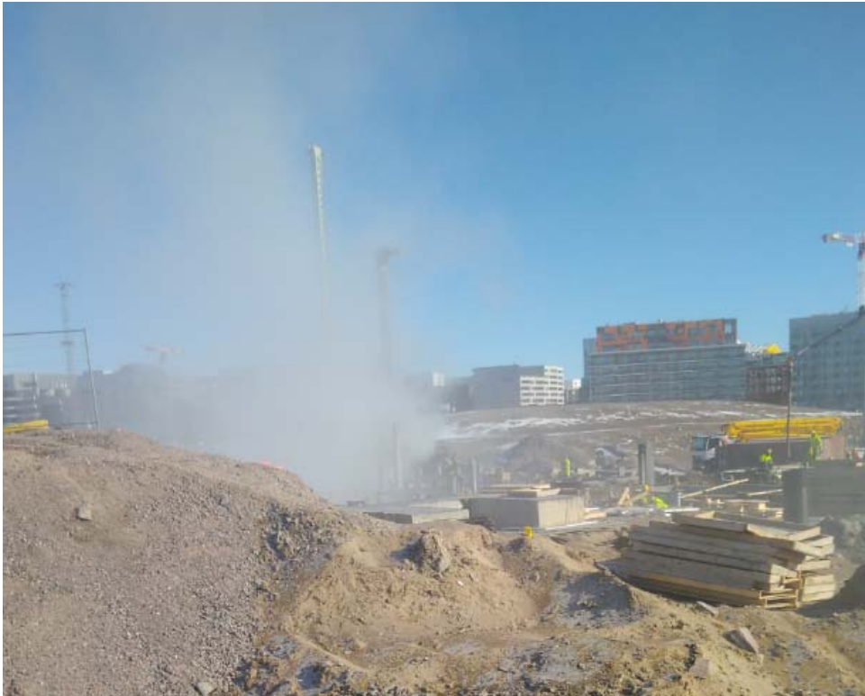
Kuva 21 Pölyäviä työvaiheita työmaalla Jätkäsaarella maaliskuussa 2018
