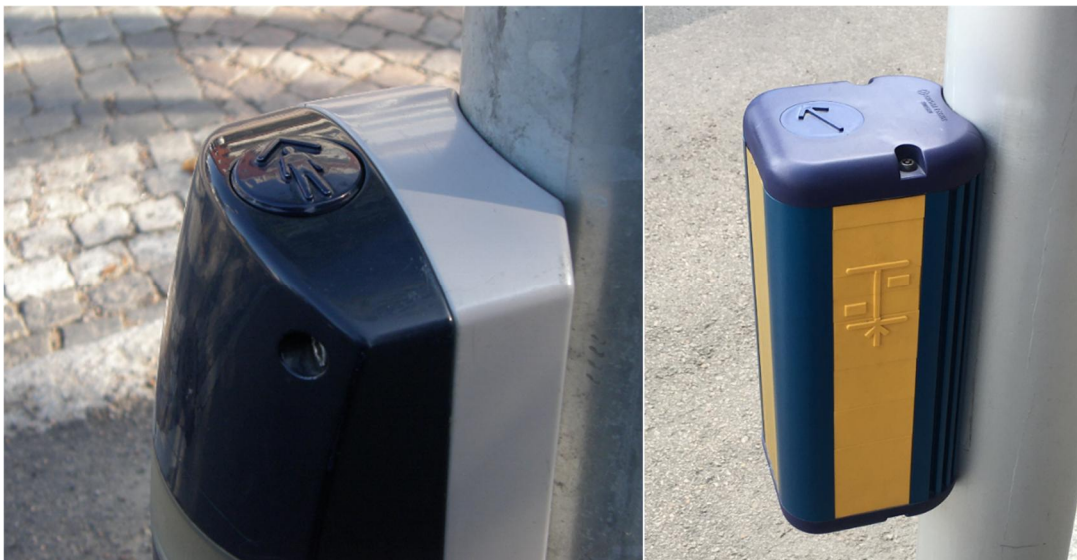
Kuva 27 Suojatien kohotunnuksia painonappikoteloissa.
