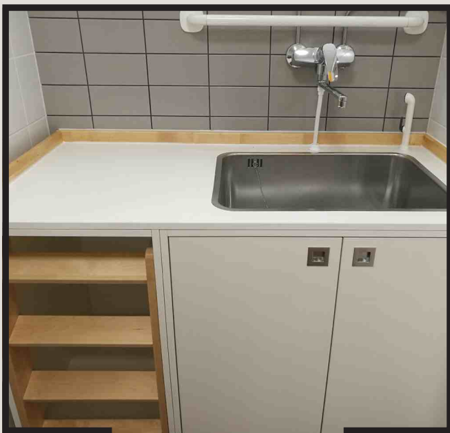
Esimerkki hoitotasokalusteesta, jossa riittävän syvä pesuallas ja integroidut tikkaat (Päivärannan päiväkot).
